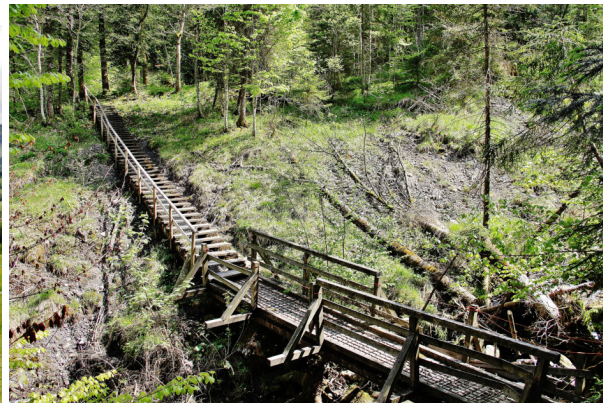
Steig über das Beientobel
